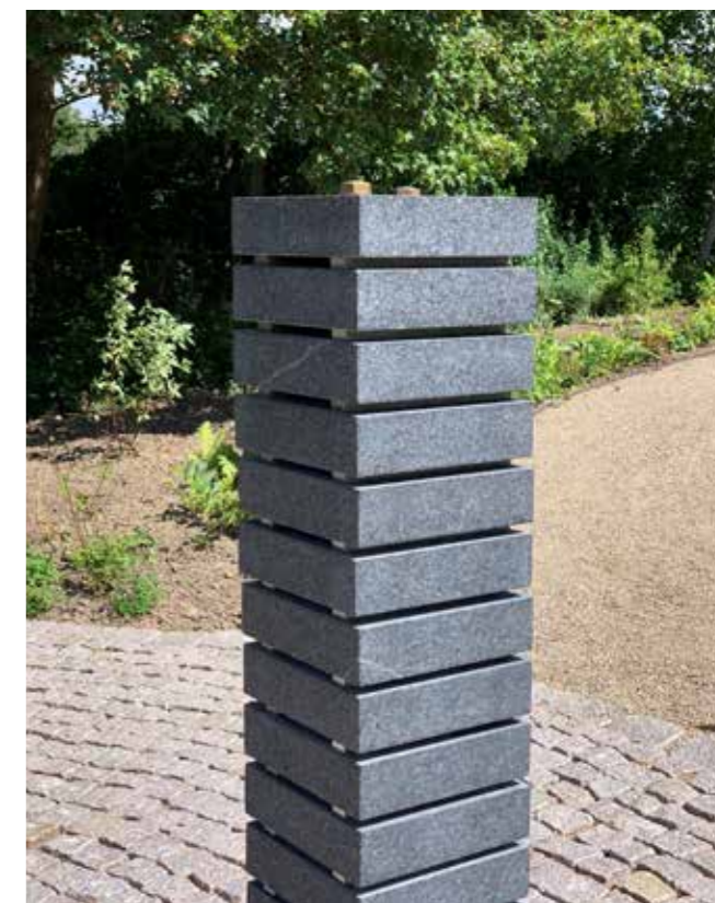
Den store søjle er lavet i Blå Rønne og er jetbrændt på alle synlige flader og måler 40x40x250 cm. Mindesøjlerne er lavet i satineret Blå Rønne og måler 29x29x24 cm. Brosten og chaussese-ten er Moselykke.
